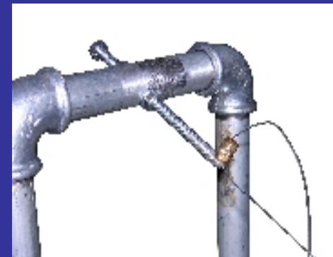
il primo sistema di aggancio del cavo al sostegno (particolare) e la soluzione definitiva (qui sotto).
